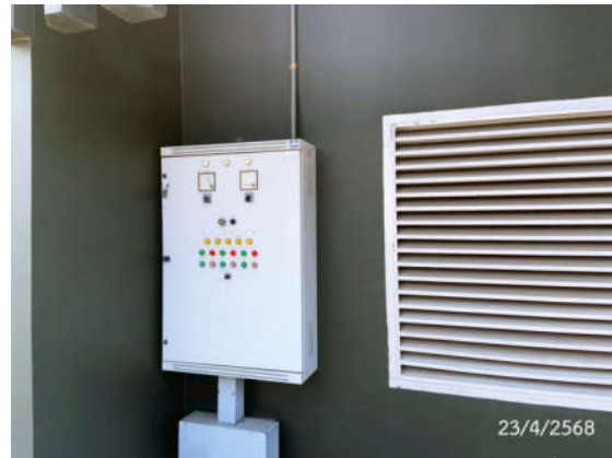
รูปที่ 2-41 ควบคุมเครื่องกำเนิดไฟฟ้า
