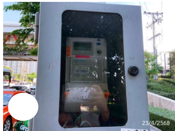
รูปที่ 2-14 ระบบมิเตอร์ไฟฟ้า
