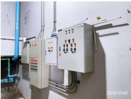
รูปที่ 2-13 ตู้ควบคุมระบบบำบัดน้ำเสีย
