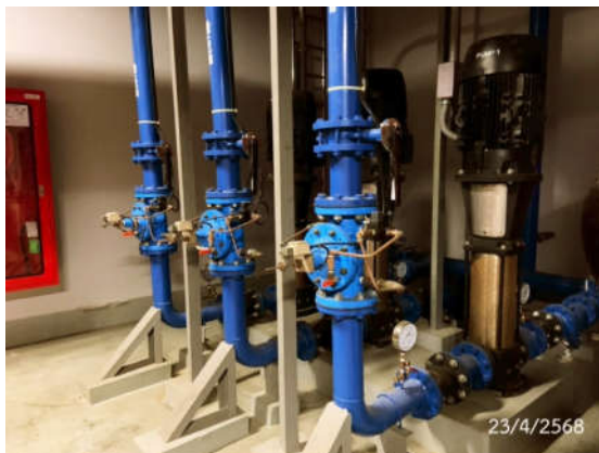
รูปที่ 2-16 ระบบสูบน้ำใช้ในโครงการ
