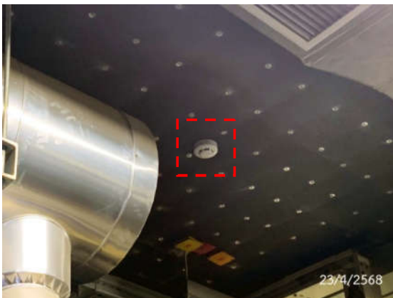
รูปที่ 2-42 อุปกรณ์ตรวจจับควันภายในห้องเครื่อง ไฟฟ้า (Smoke Detector)
